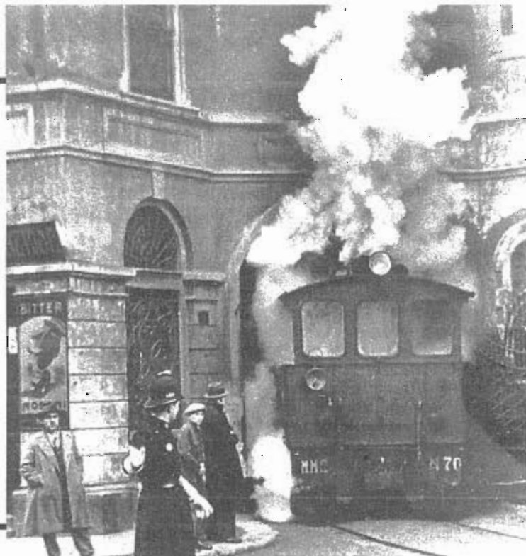
Il Gamba de legn esce dal deposito di Corso Vercelli
