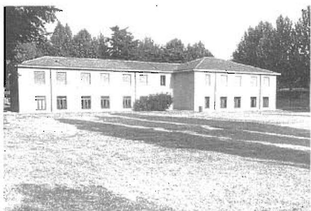
Il terreno su cui sorgerà la palestra: sullo sfondo la scuola elementare di Vighignolo
