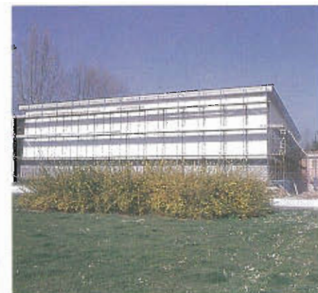
Vighignolo: palestra in costruzione alle scuole elementari
