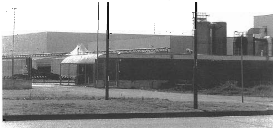
L'ingresso dell'impianto di compostaggio
