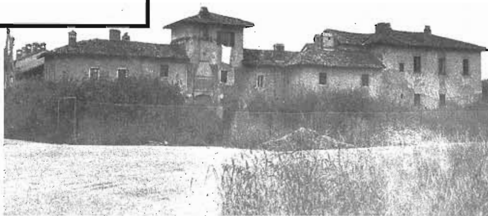
Una delle ultime immagini della Cascina prima della demolizione
