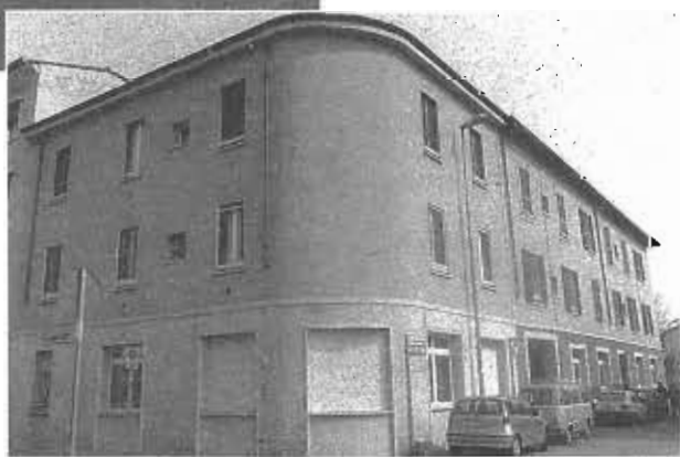
Lo stabile in via Garibaldi
