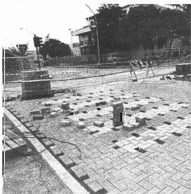
Lavori in via Libertà, angolo via Grandi
