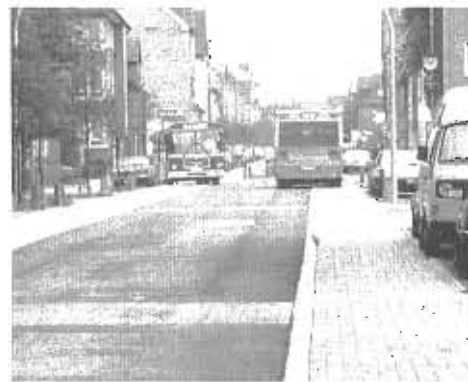
Una efficace forma di moderazione dei comportamenti e di protezione delle biciclette può essere rappresentata dall'inserimento di bande laterali, che restringono otticamente le corsie di marcia senza per questo ostacolare la marcia dei veicoli più ingombranti...
