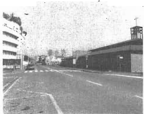
Via Di Vittorio, di fronte alla chiesa di S. Giovanni: la larghezza della strada induce velocità eccessive.
