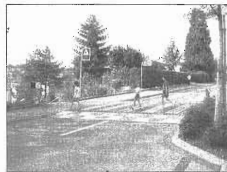
La tecnica dell'attraversamento rialzato viene proposta per moderare la velocità in via Di Vittorio, così come in molti altri luoghi di Settimo.
