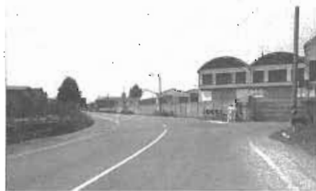
Il tratto di via Edison tra via Meucci e via Keplero richiede un intervento unitario, rivolto soprattutto ad impedire le velocità eccessive ed i sorpassi azzardati
