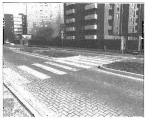
Il dispositivo di protezione dell'attraversamento pedonale realizzato su via Di Vittorio va completato con dispositivi di rallentamento del traffico ed inserito in un intervento complessivo, esteso all'intero asse.
