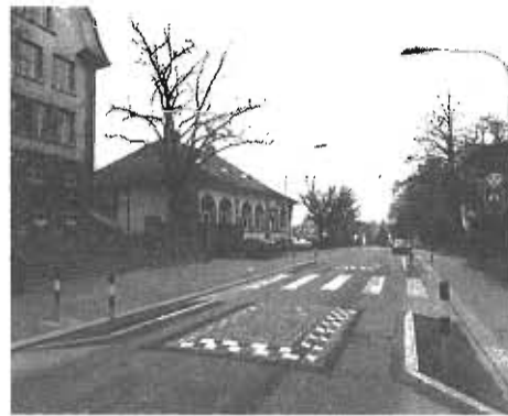
Il cosiddetto "cuscino berlinese" è un esempio di dispositivo di rallentamento utilizzabile sulla via per Vighignolo, prima dell'incrocio con via Moro.
