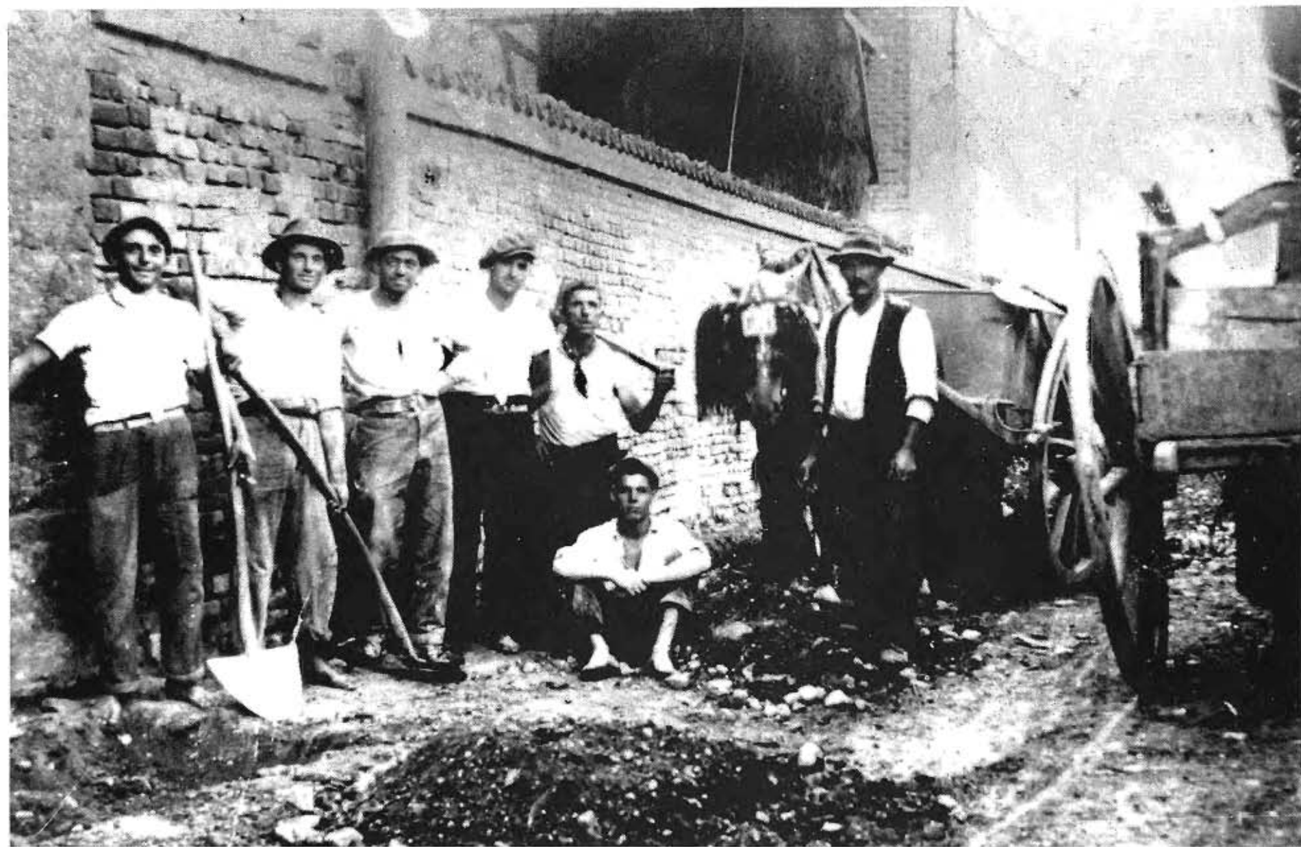
Lavori in via Ciniselli - fine anni '20
