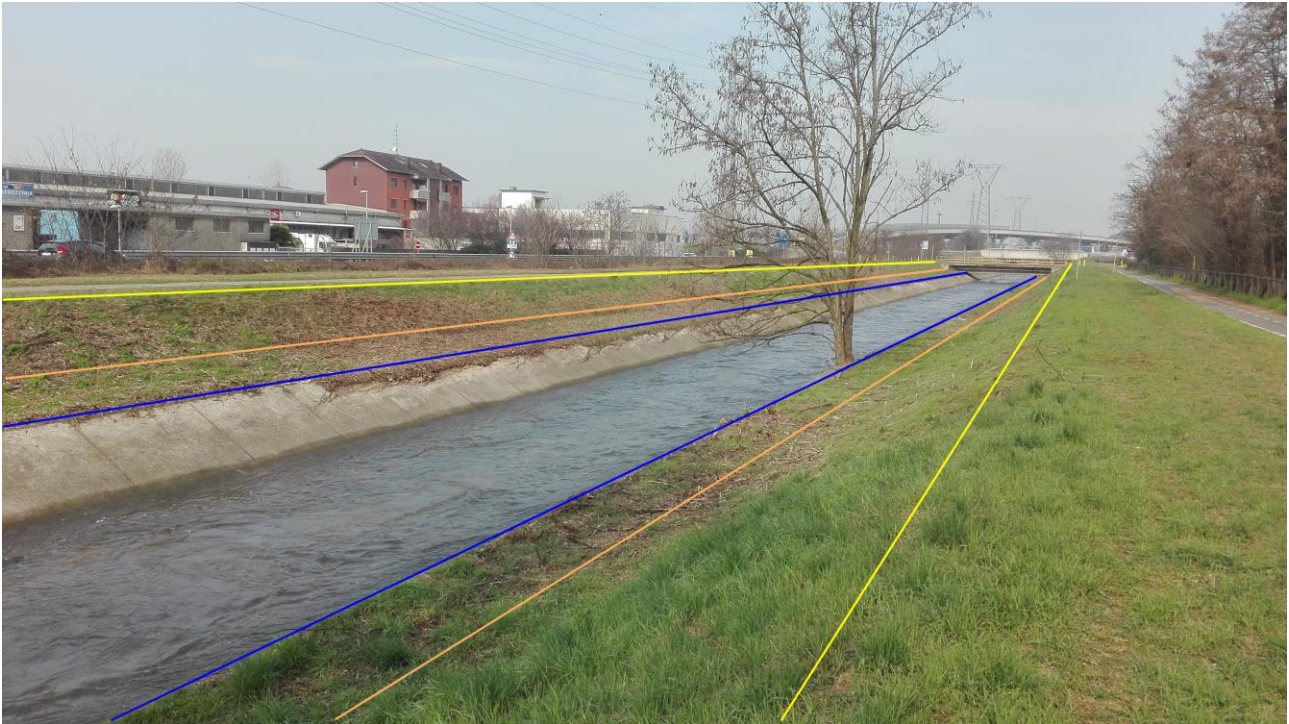
Figura 3. Tratto tipo del Canale Scolmatore Nord Ovest, con modesto rilevato arginale in frodo.
