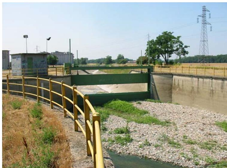
*Figura 3: la separazione tra Scolmatore delle piene NO (diritto) e Deviatore Olona (sx)*
