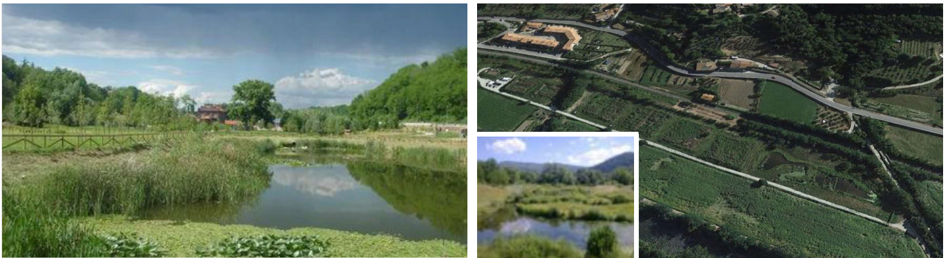
Es. Impianto di fitodepurazione con filtri verticali seguiti da sistema a superficie libera e Impianto multistadio verticale-orizzontale-superficie libera (Riferimenti a pag.15 Abaco)
